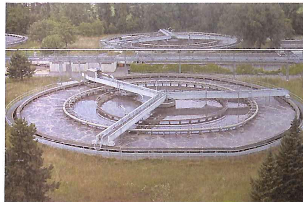
Figura 19.7 Planta de aguas residuales por el método de lodos activados, en Constanza (Alemania)
