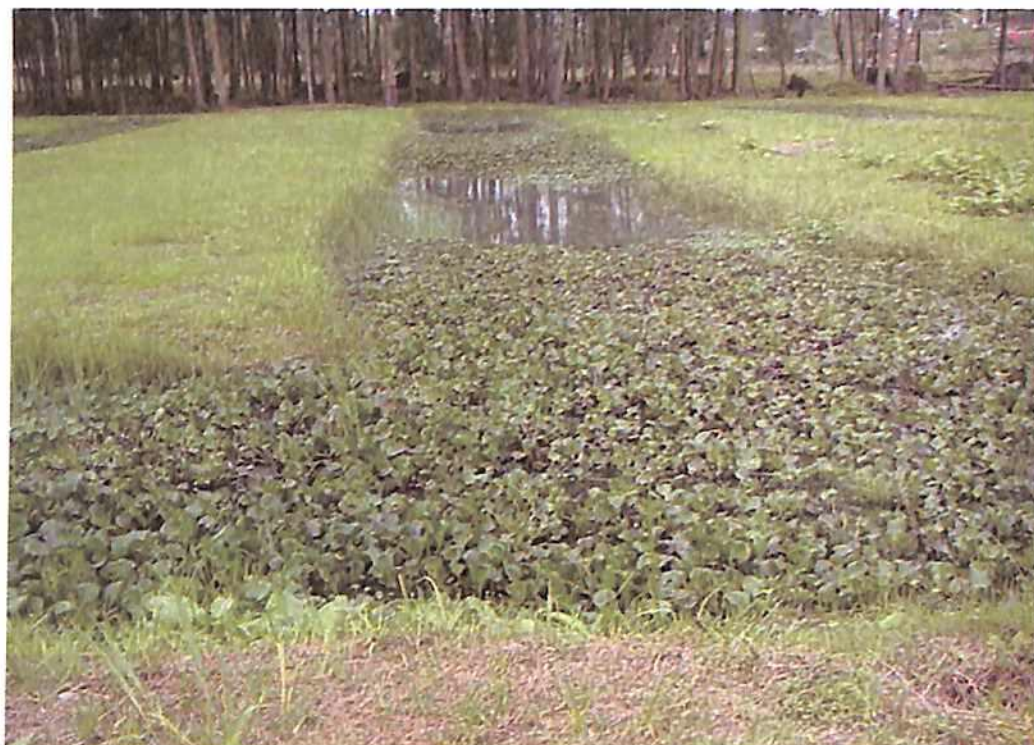
Figura 19.10 Tratamiento de aguas residuales en la fábrica de Imusa, Rionegro (Colombia)
